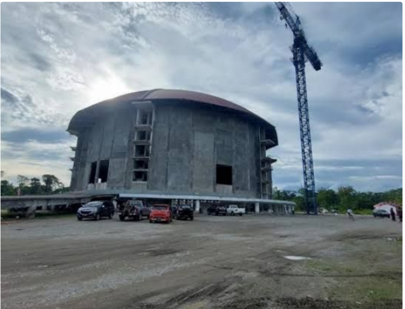
Pembangunan Gereja Kingmi Mile 32
